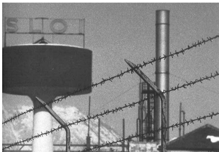
La cisterna e la ciminiera della Sloi, quando era ancora in produzione
